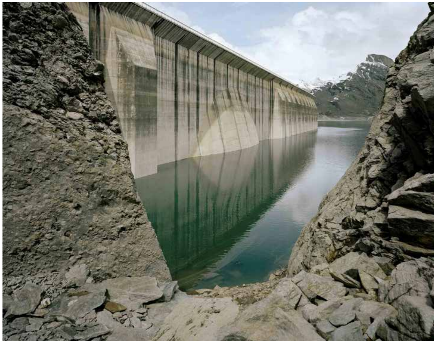
Barrage de Roselend, parement amont © Céline Clanet / Fondation Facim
